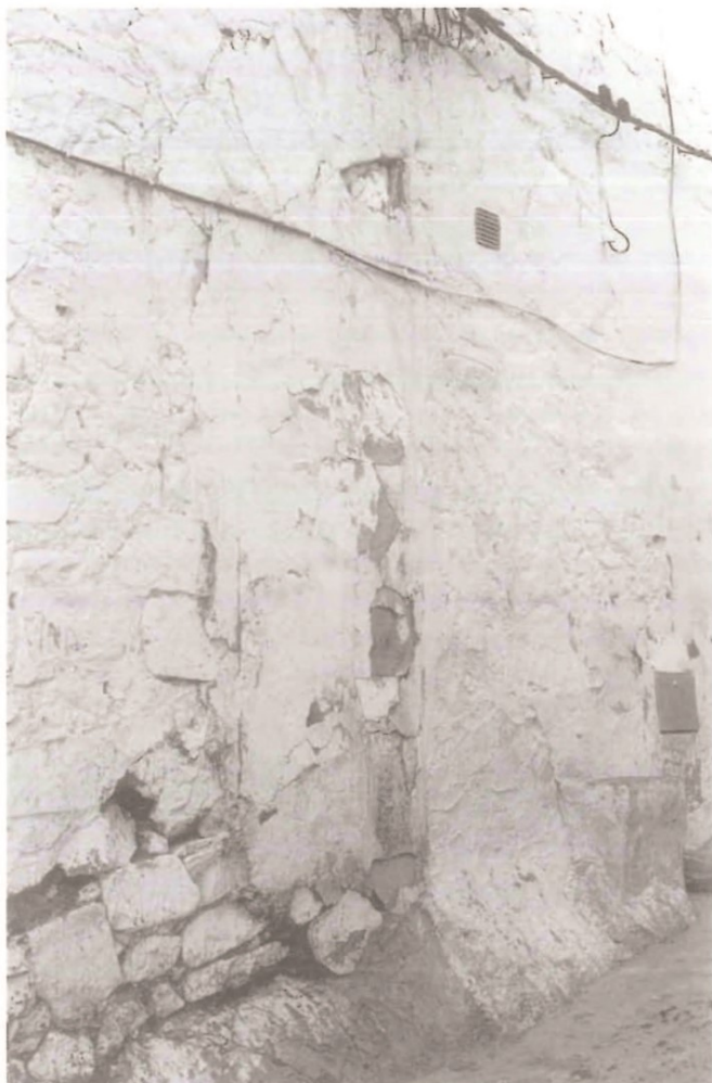
Ejemplar de puerta dovelada, actualmente cegada.
