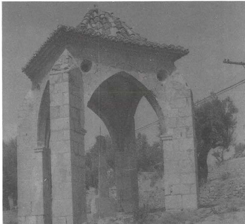
"La Cruz cubierta de Jérica se halla a la vera de la antigua carretera, en dirección a Segorbe, cercana al río Palancia y al puente de Muñatones sobre el mismo. Data de 1511 y fue reformada en el siglo XVIII. Cuatro pilares estribados, de sillería, de cuyas impostas en la zona interior arrancan los arcos góticos, bóveda nervada y cubierta de teja árabe vidriada, conforman este ejemplar único en la comarca. En la zona que pudiéramos definir como alfiz lleva dos pequeños óculos por lado. La plementería de la bóveda y el intradós de los arcos fueron pintados en el siglo XVIII".
