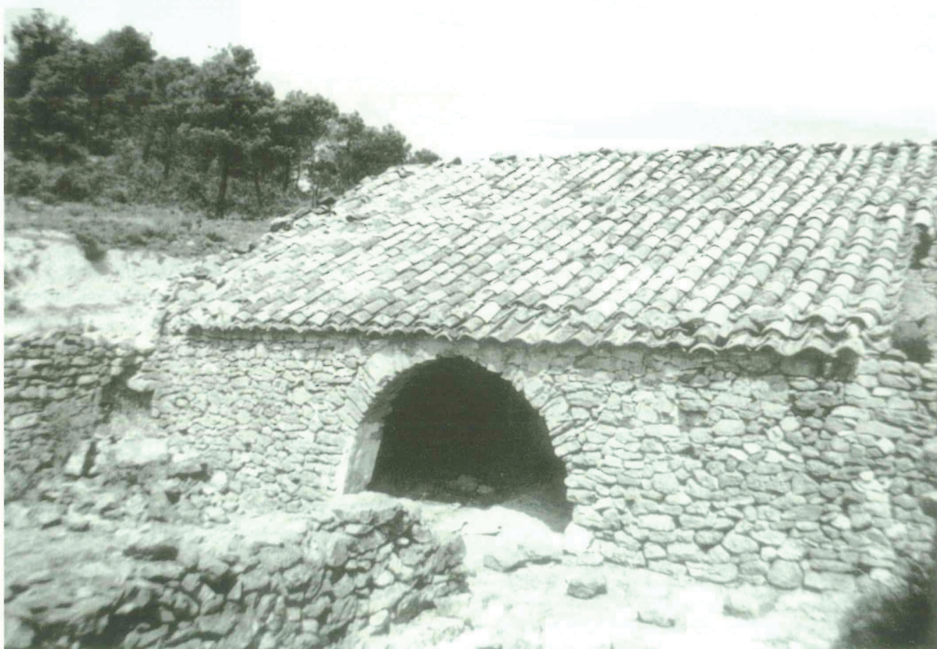
Corral del Cerro Las Mulas (parte delantera). Construcción en piedra en seco.
