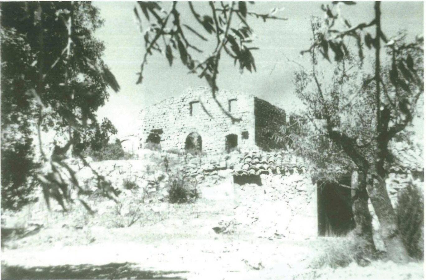
Corrales de Vergara. Piedra con juntas de mortero. Vivienda y corrales. Situado en una zona de cultivo de almendro.
