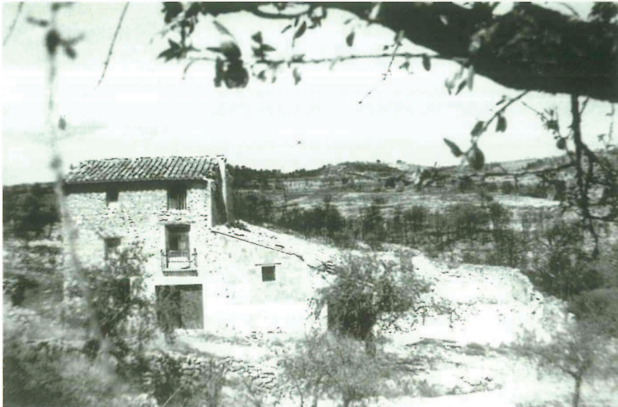
La Masadica del Rejo. Vivienda independiente de 3 pisos. Construcción de tapial.
