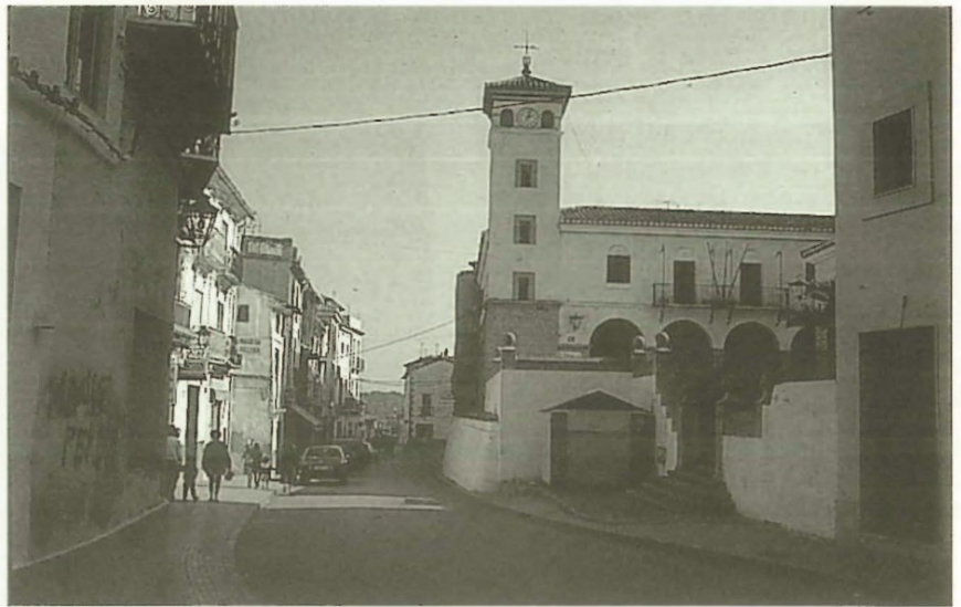
Casa Consistorial (obra de "Regiones Devastadas").
