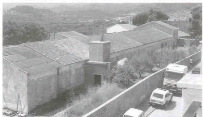
La fábrica textil de Castellnovo, fundada por los Hermanos José y Orfelino Almela a principios del siglo XX, fue durante años la fábrica textil más importante de la comarca, ampliando sus instalaciones a Segorbe, donde adquiriría la antigua fábrica de seda.
