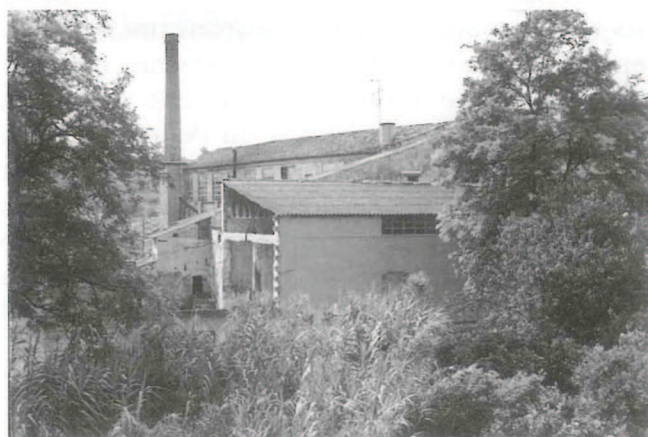
La fábrica de papel continuo de José María Canelles Peregrín de Soneja estaba situada en la margen derecha del río Palancia para aprovechar el abundante caudal de agua, tan necesaria en este tipo de actividad.
