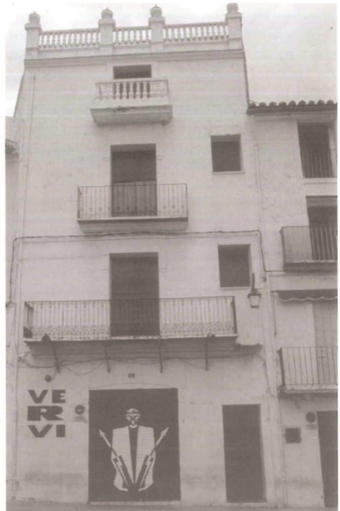
La Peña Torres, también conocida por otros como el Casino, estaba situada en este edificio, hoy dedicado a pub. A él solo podían acceder socios, generalmente personas pudientes y funcionarios. Probablemente el Casino al que hace referencia.
