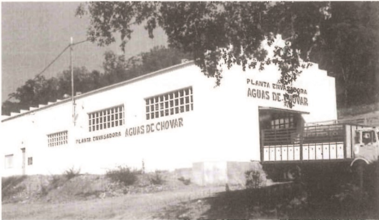
Edificio de la Envasadora.
