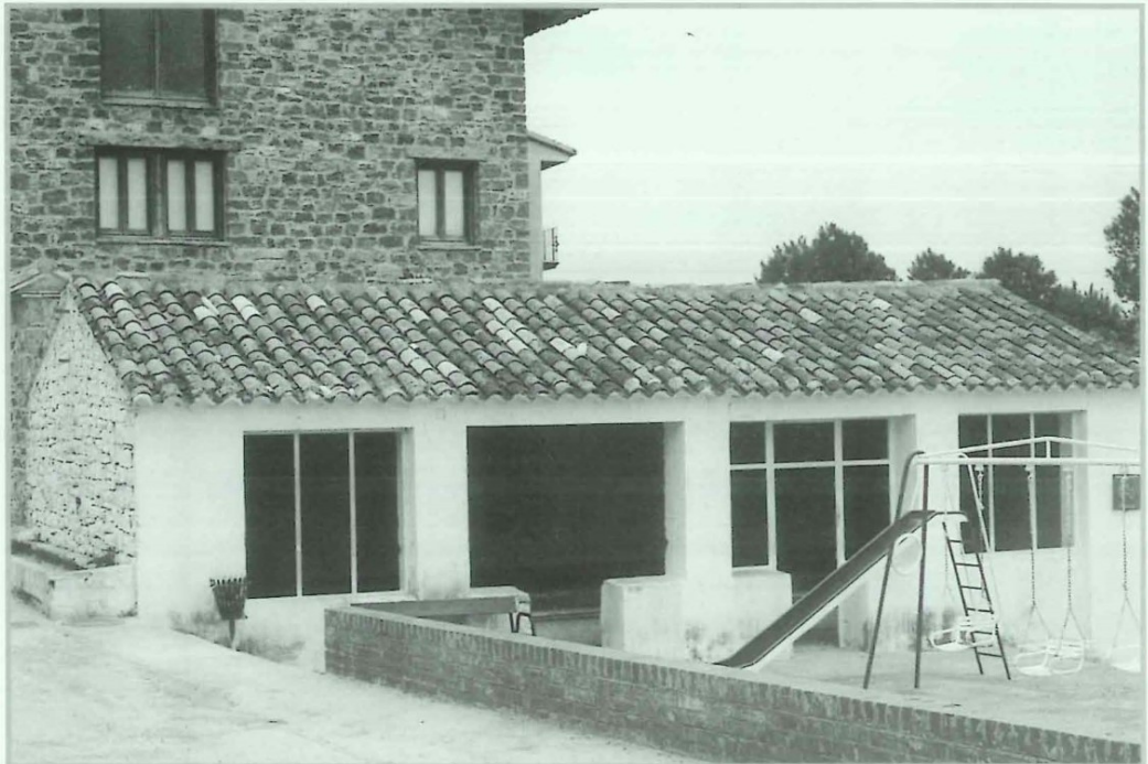
Exteriores del Lavadero Nuevo.
