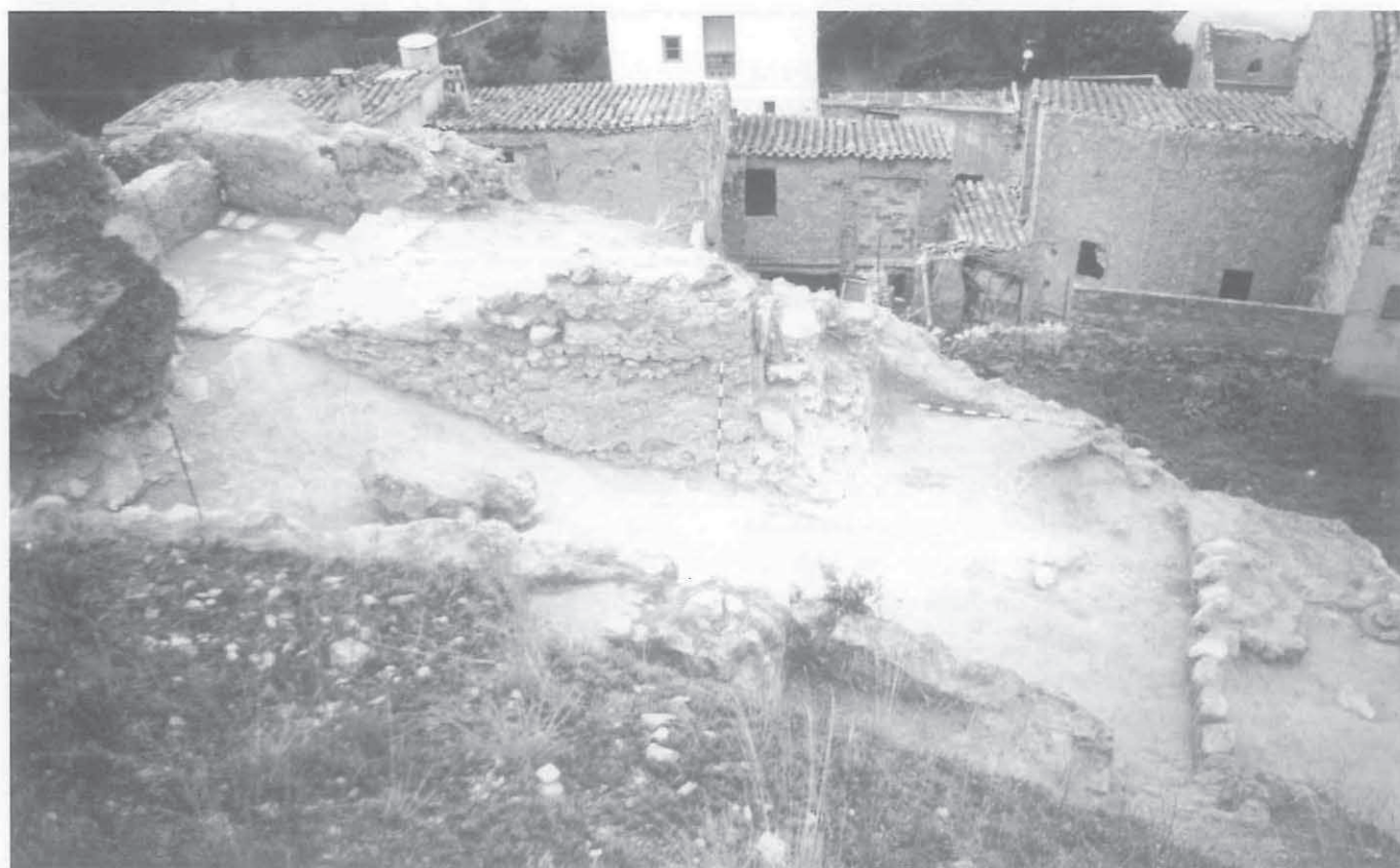
Ilustración nº 6.- Detalle de la puerta de acceso al recinto amurallado del Castillo. Año 1997. Fotógrafo S. Selma.
