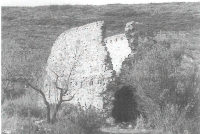
"La Torreta", adosada a la torre medieval, una cisterna de planta rectangular y bóveda., probablemente unica en la Comarca.
