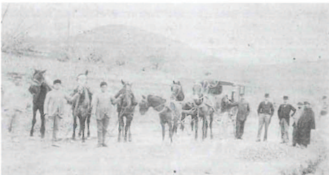
Los ingenieros belgas en Jérica para realizar los proyectos de explanación y obras de fábrica.
