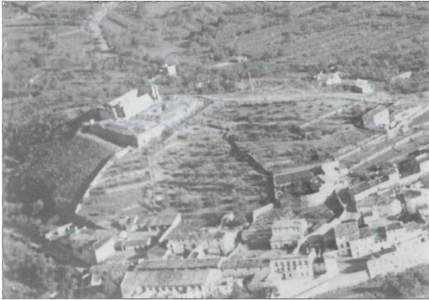
Detalle de las ruinas de San Blas. Permanece en pie la Iglesia del monasterio, transformada en cuartel para la tropa en 1876. Se aprecian igualmente los muros perimetrales de la fortificación, la rampa de acceso al recinto y el hueco de la cisterna.
