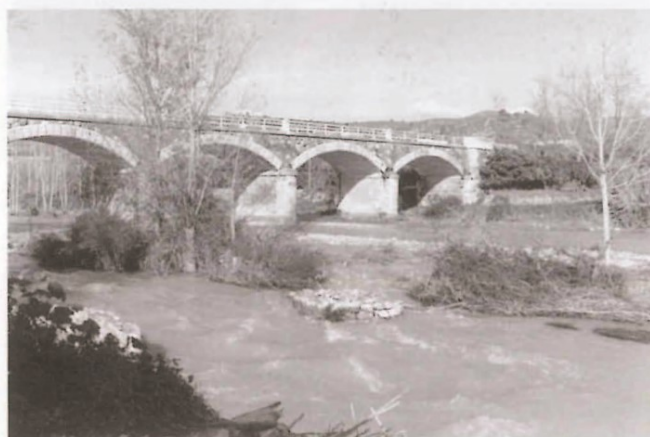
Puente de la Fábrica.
