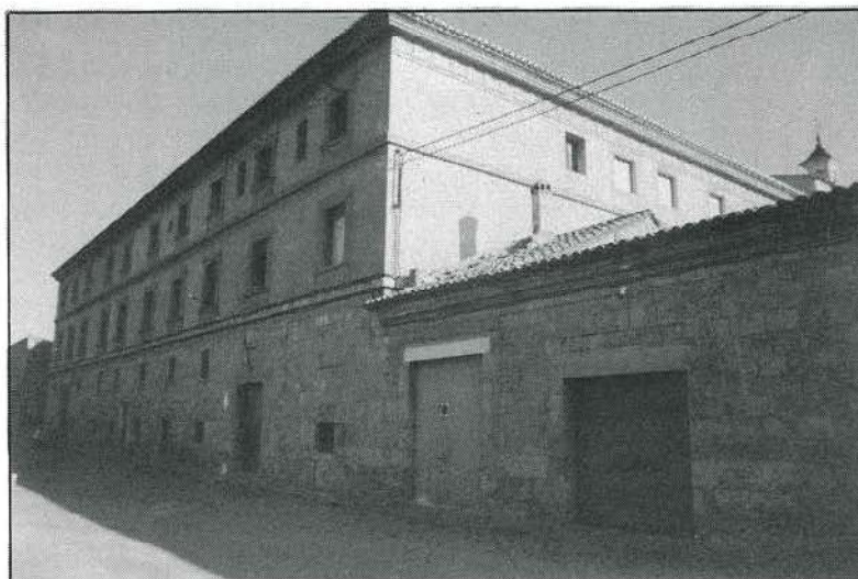
Segorbe. Hospital y Casa de Misericordia. Exterior del edificio. (Foto del autor.)
