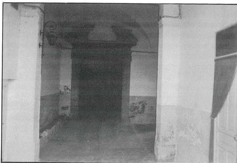
Segorbe. Hospital y Casa de Misericordia. Portada de acceso a la antigua capilla. (Foto del autor.)
