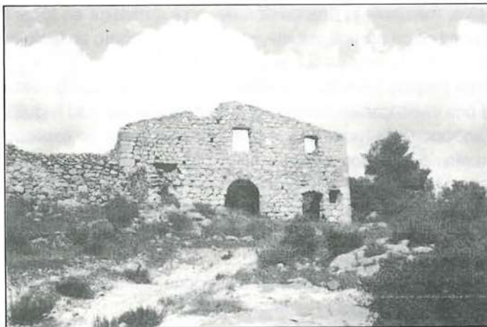
Ruinas del oratorio en el Mas de Bergara, de Altura. (Foto V. Górriz.)
