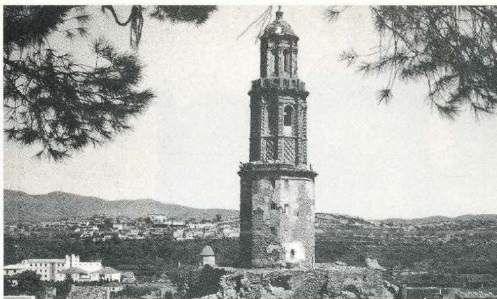
Vista de la torre sobre el promontorio murado que le sirve de base
