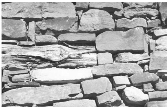
Detalle de un corral de ganado construido con piedra arenisca y madera de sabina. El Toro (Foto: Jorge A. Gago)
