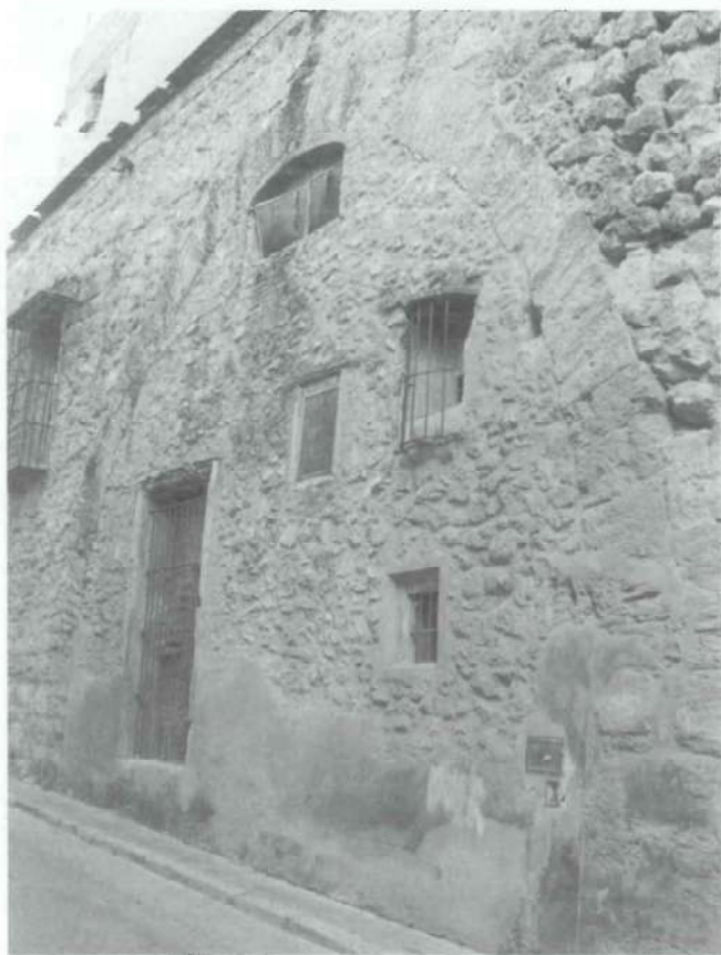
Fig. 17 - Aspecto del Acueducto en la calle Argén con el arco aún cegado en el que se abren numerosos vanos para dar luz a la vivienda adosada por la Plaza de los Mesones.
