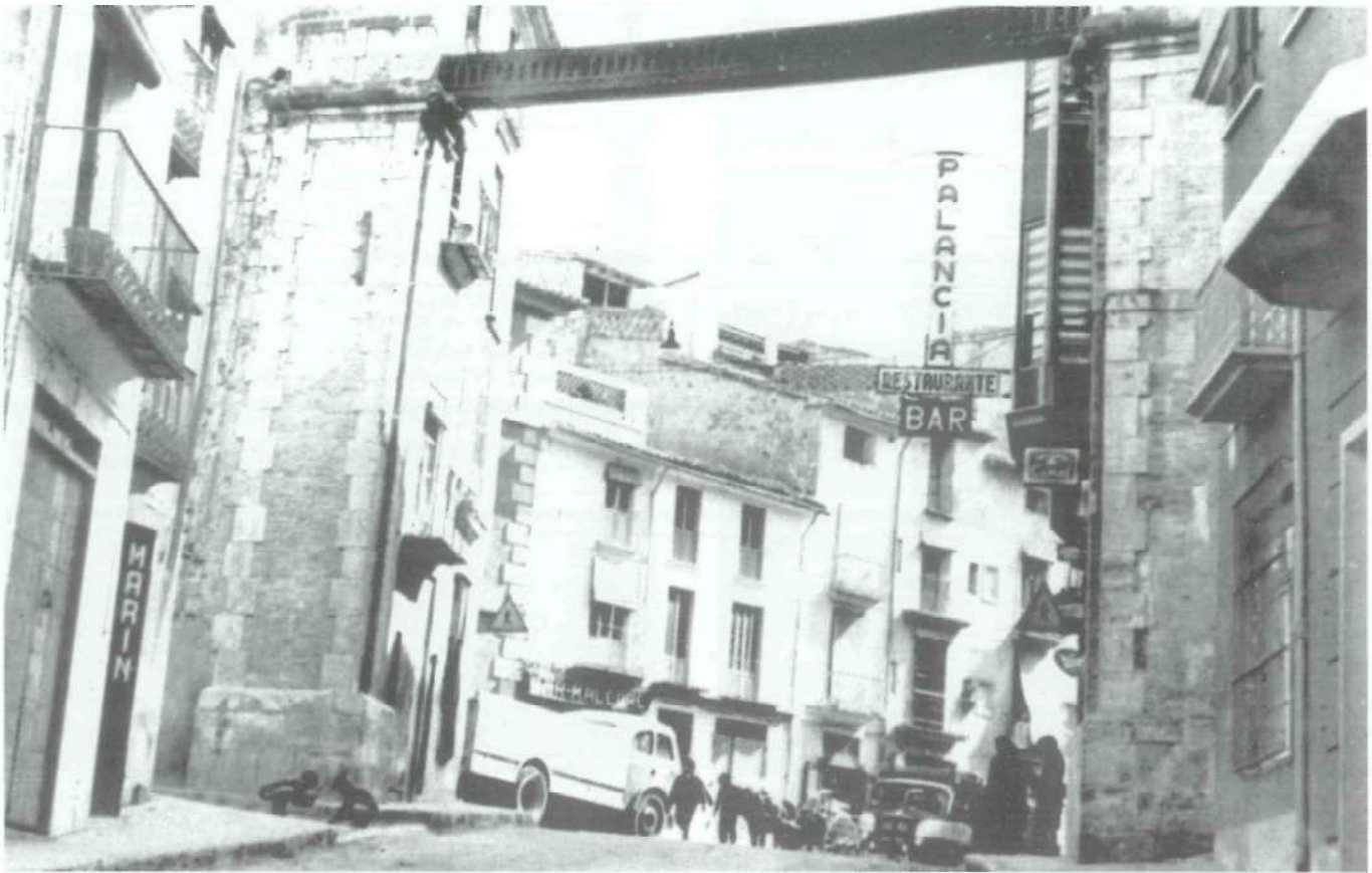
Fig. 19 - Aspecto del canal de hierro del Acueducto poco antes de desplomarse (fotografía propiedad de Rosa Sánchez López).
