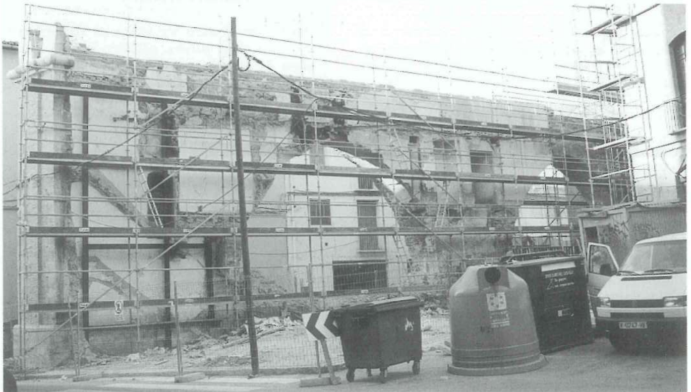
Fig. 22 - Vista del Acueducto en proceso de restauración una vez derribadas las viviendas que lo ocultaban.
