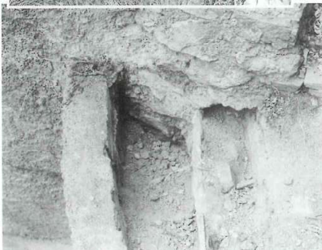
Fig. 9 - Vista de la acequia del Acueducto en el tramo de muralla una vez pasada la torre del Botxí.
