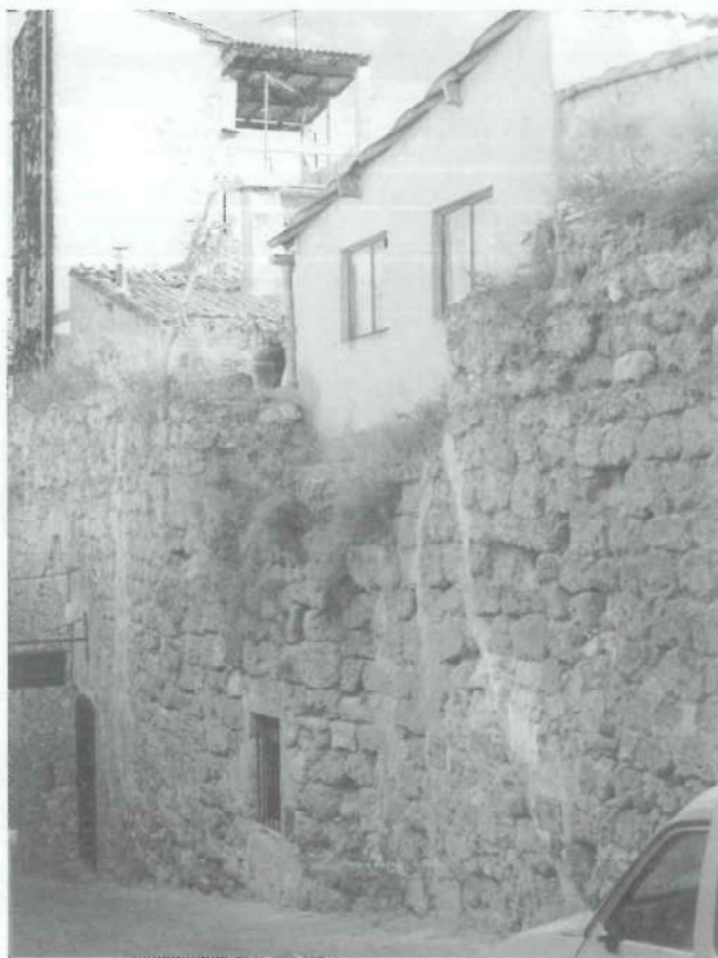
Fig. 18 - Vista del Acueducto en la calle Muralla, en la que se aprecia la destrucción de parte del muro al edificar la vivienda adosada por su interior.
