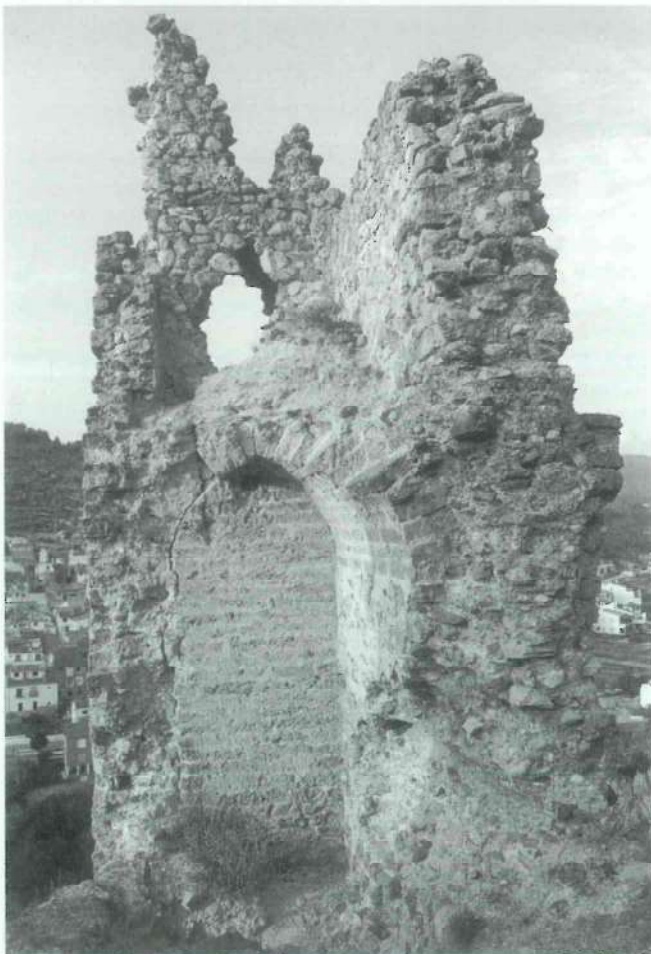
El Castillo. Detalle de un muro interior.
