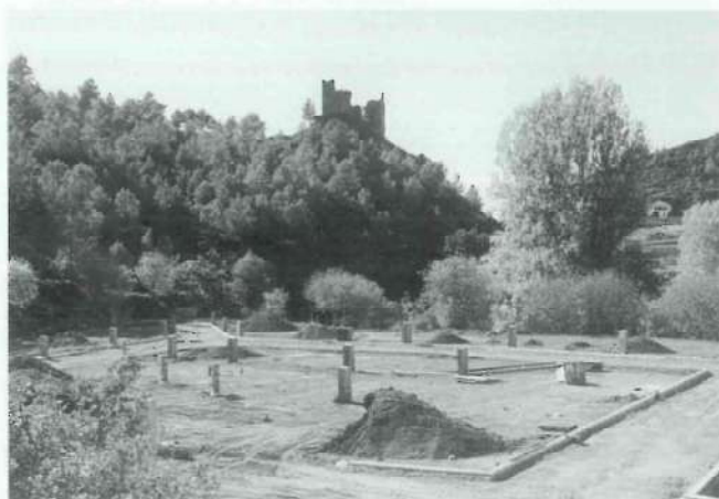
Obras de construcción del Camping.
