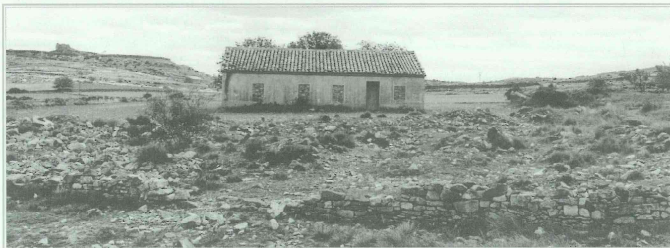
Aeródromo de El Toro. Estado actual de lo que fue la Casa de Mando del aeródromo, indicada en el plano como "Paridera" arreglada para uso de los oficiales. En ella estaba el Estado Mayor de las escuadrillas que operaban en el aeródromo, junto a ella existía un refugio cuyas ruinas se conservan hoy en día y que se aprecian junto a la casa en la parte derecha de la foto (Carlos J. Sánchez).
