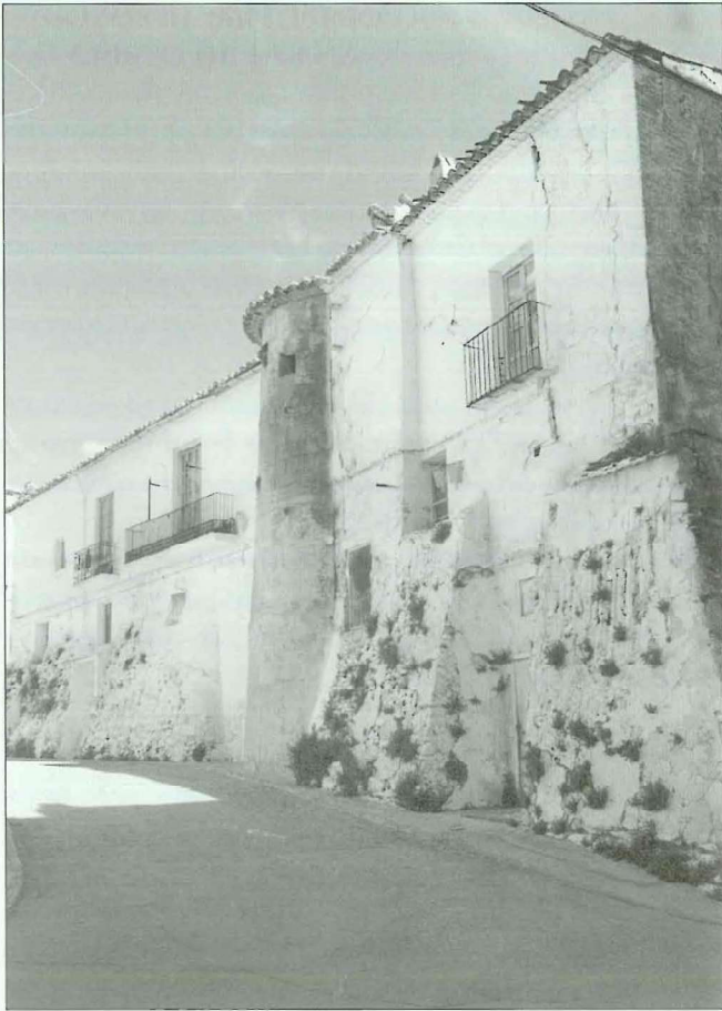
Detalles de la fachada principal del edificio.
