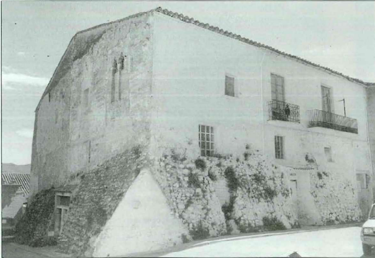
Visión de la fachada oeste del edificio.
