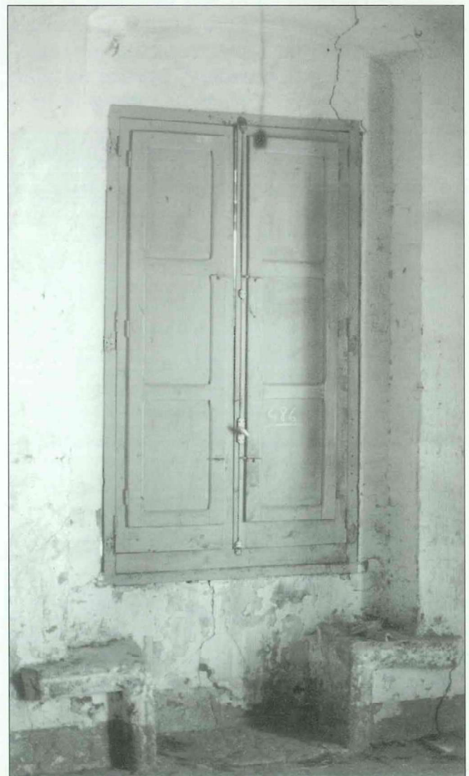
Ventana fachada este (interior).
