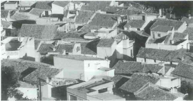
Tejados irregulares, vistos desde el monte de la Pedrera.
